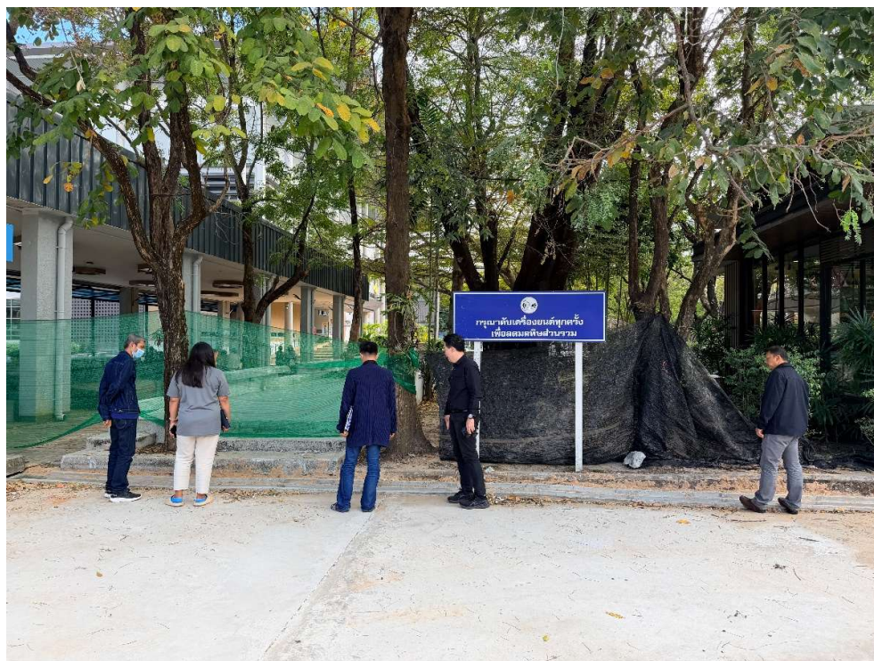
ภาพถ่ายการตรวจรับงานจ้างก่อสร้างปรับปรุงลานจอดรถยนต์ (พฤศจิกายน ๒๕๖๘)
