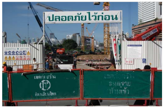
ป้าย และเครื่องหมายในสถานที่ก่อสร้าง
