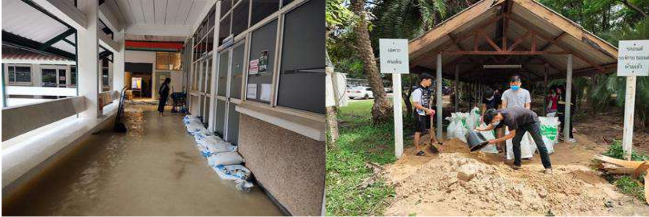
ภาพที่ 5 จิตอาสาขนย้ายกระสอบทราย ป้องกันน้ำท่วมอาคารบริหารศาสตร์ (หลังเก่า)
