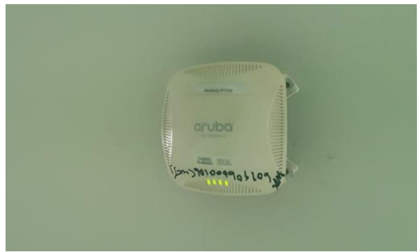
รูปภาพที่ 62 การติดตั้ง Access Point สำหรับให้บริการ WiFi บริเวณอาคาร
