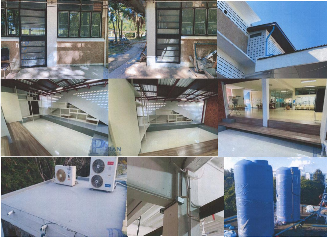
ภาพที่ 62 การปรับปรุงอาคารคณะศิลปประยุกต์และสถาปัตยกรรมศาสตร์
