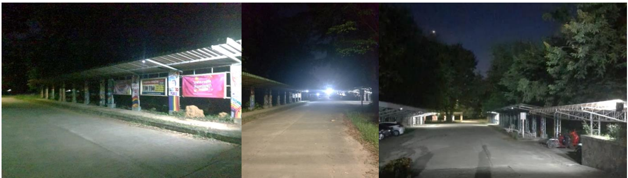
ภาพที่ 63 การติดตั้งไฟส่องสว่างบริเวณคณะ
